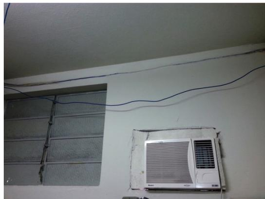
*Foto 10: Interior do prédio que abriga as instalações do extinto Departamento de Assistência Estudantil (DAE), com destaque para os cabos da rede lógica expostos e para a abertura na parede, que é muito maior do que o condicionador-de-ar nela instalado – Recife, 5 de agosto de 2016.*
