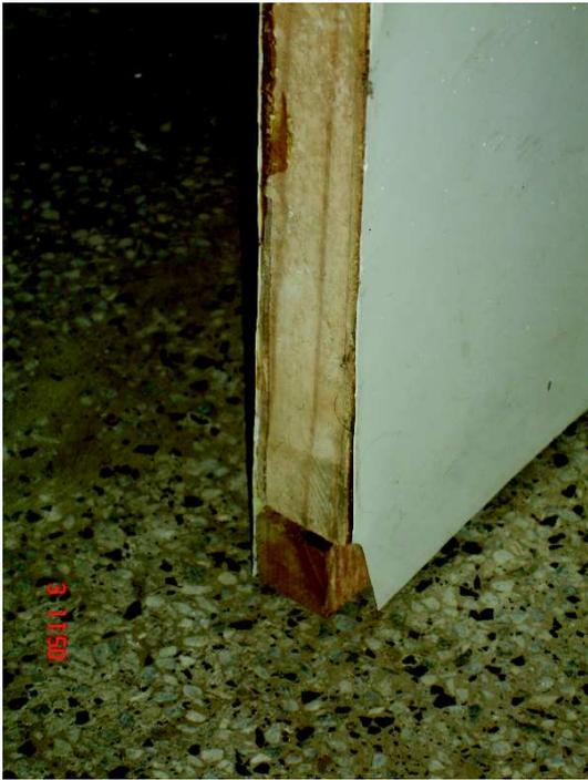
Blocos de Salas de Aulas: Pedaco da porta arrancado e revestimento em fórmica branca soltando-se.
